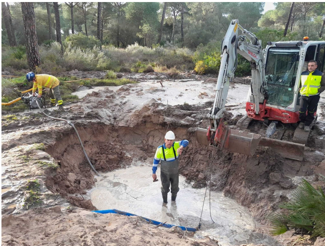
Trabajos de reparación en Hinojos. / PLAN INFOCA
